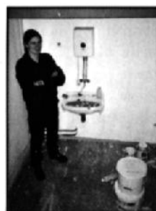
„Ein Problem nach dem anderen. Z.B. kommt Wasser aus der Wand, aber an der falschen Stelle“, so Oliver.
